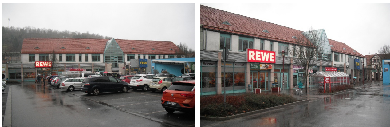
Abbildung 1: Objektsituation in dem Einkaufszentrum in der Renthofstraße in Schmalkalden
