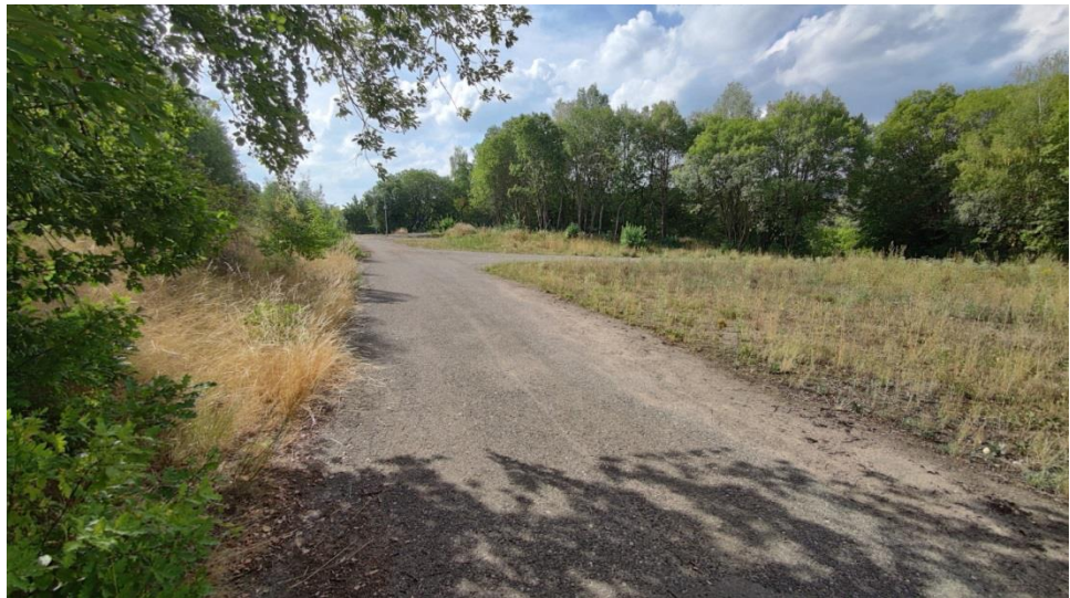
Abbildung 2 Ansicht der östlich gelegenen Terrasse von Norden
