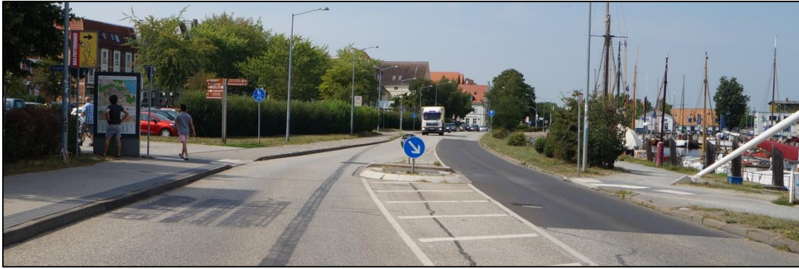
Abb. 29 Beispiel Aufhebung Busbucht zur Schaffung einer Querungsstelle
