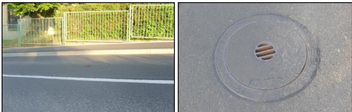
Abb. 27 Lärmarme Schachteindeckung (Beispiel Dresden)
