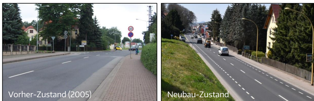
Abb. 25 Vorher-Nachher-Situation Kassler Straße
