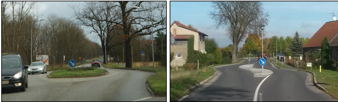
Abb. 26 Beispiele Ortseingangsgestaltung mit Fahrstreifenversatz
